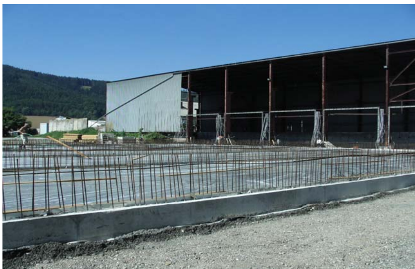
Obr. č. 2 Stavba reaktorů do velkokapacitního seníku
